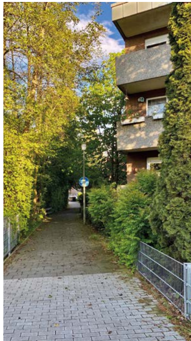
Der Gehweg Lammerbach von der Dorbaumstraße bis zur Hobbeltstraße gehört zu den beschlossenen Baumaßnahmen.
